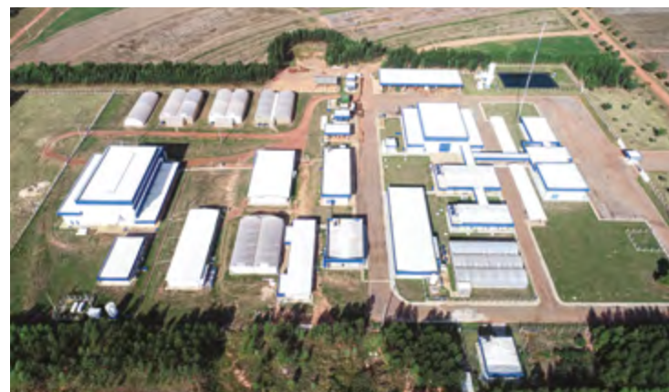
Construção dos Centros de Treinamento e Difusão Tecnológica - Ampa
